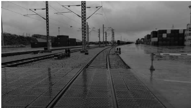
写真2. 昆明センター駅構内の縦列貫通式「線束」（筆者撮影）
